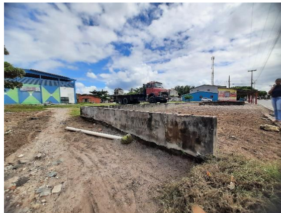
Imagem 04: Vista do terreno com o talude existente Autoria: Equipe de Engenharia e Arquitetura PMP
