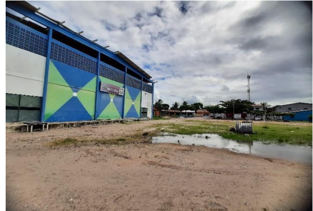
Imagem 02: Vista dentro do terreno frente com a quadra poliesportiva. Autoria: Equipe de Engenharia e Arquitetura PMP
