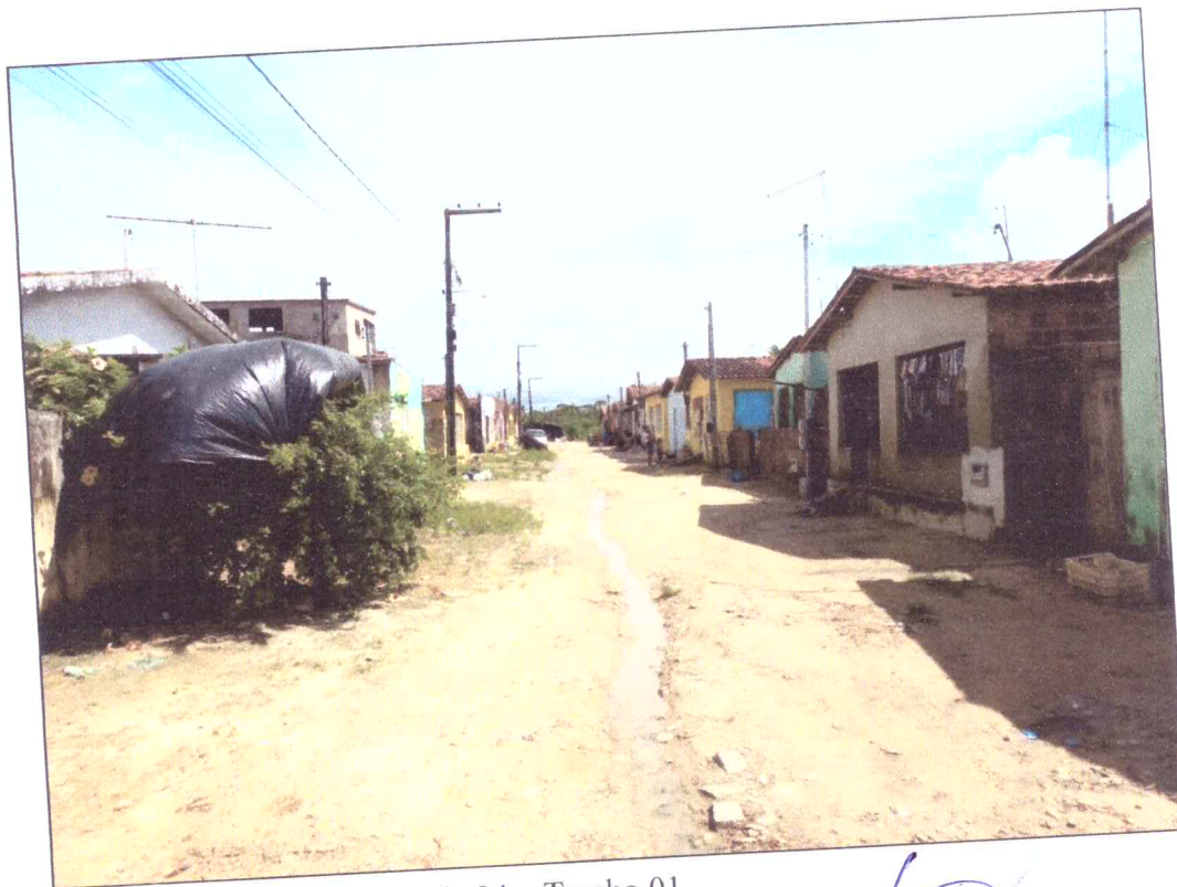
Imagem 08 – Rua Projetada 04 – Trecho 01
