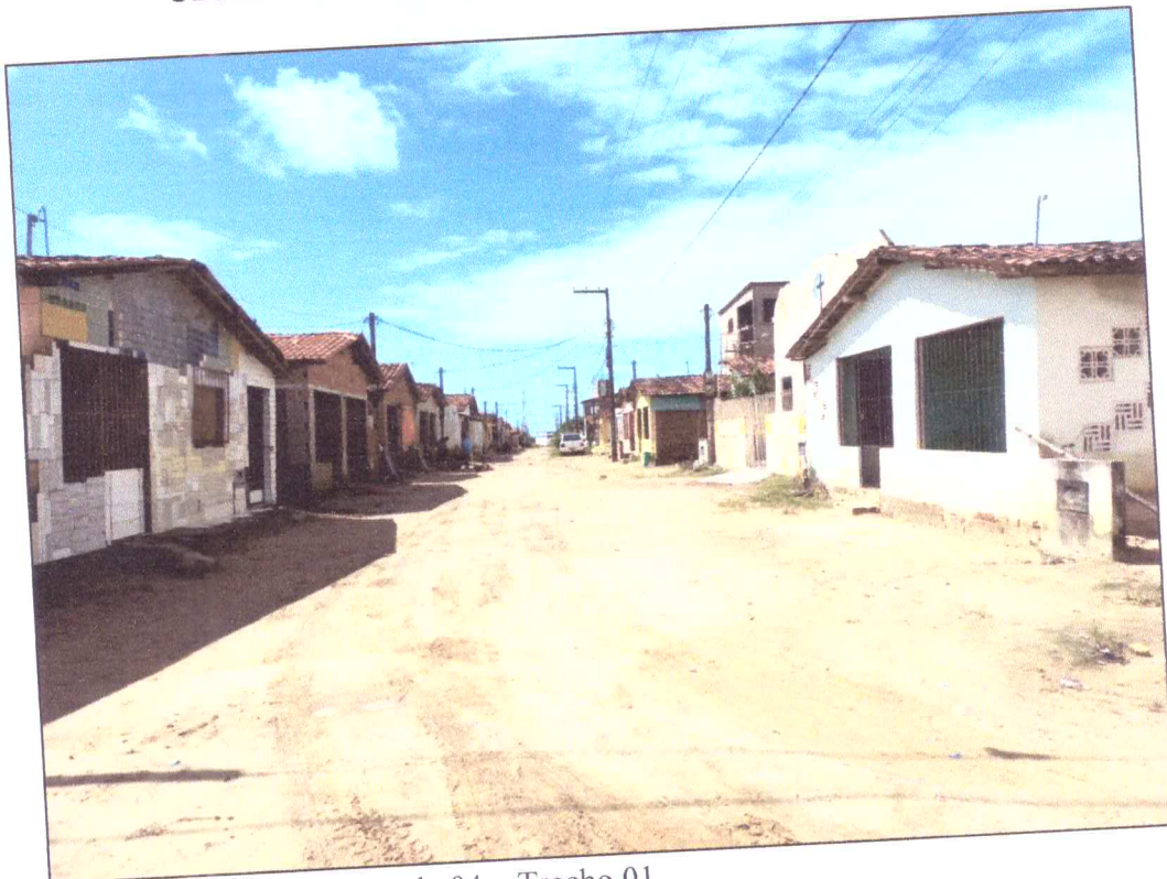
Imagem 07 – Rua Projetada 04 – Trecho 01
